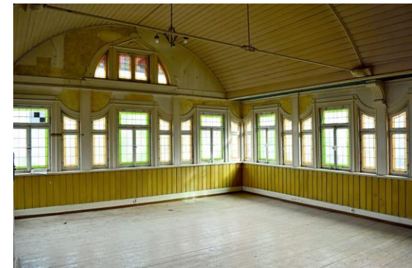
Einer der beiden Jugendstilsäle des denkmalgeschützten Gebäudes. Foto: Schwarzwälder Bote
